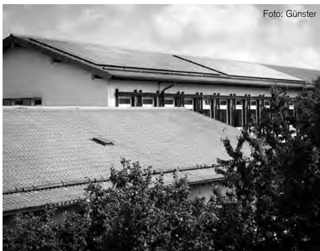
Vor 20 Jahren ist die Fotovoltaikanlage montiert worden.
