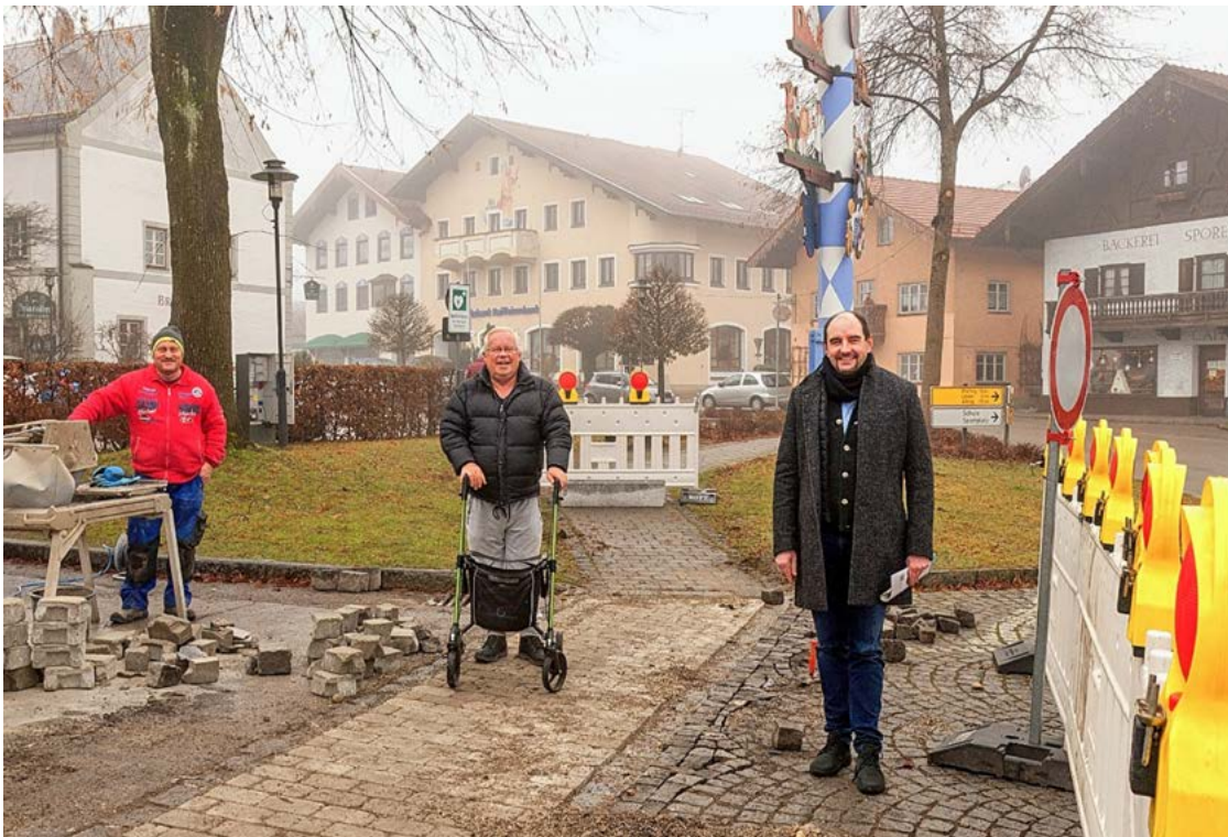
Foto: Bürgermeister Daniel Wendrock und Behindertenbeauftragter Richard Helm machen sich ein Bild vom Umbau des Gehwegs an der Sparkasse (Dezember 2020)
