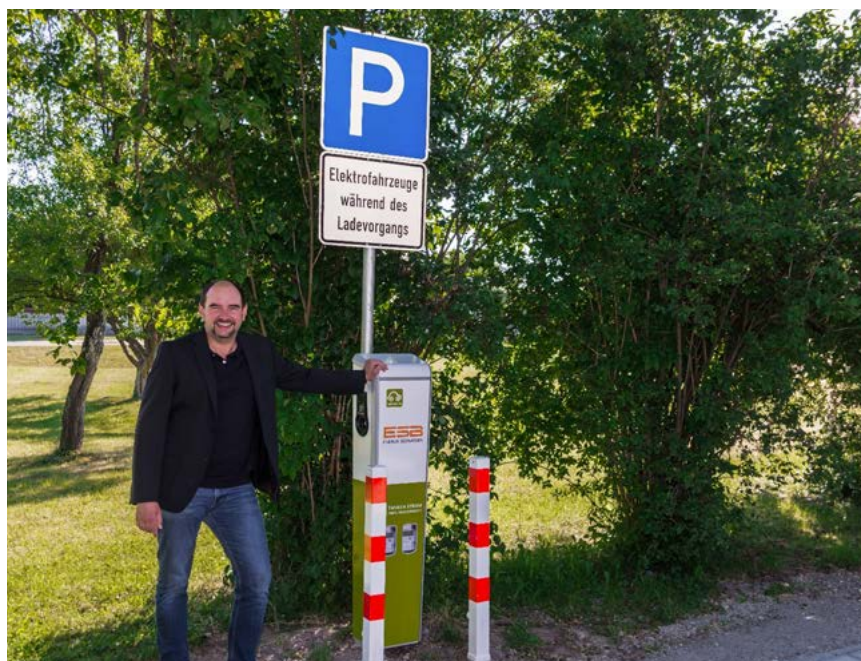
Foto: Bürgermeister Daniel Wendrock vor der neuerrichteten E-Ladestation
